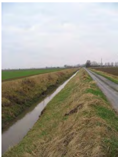
Méteren Becque – Rue du Courant amont
