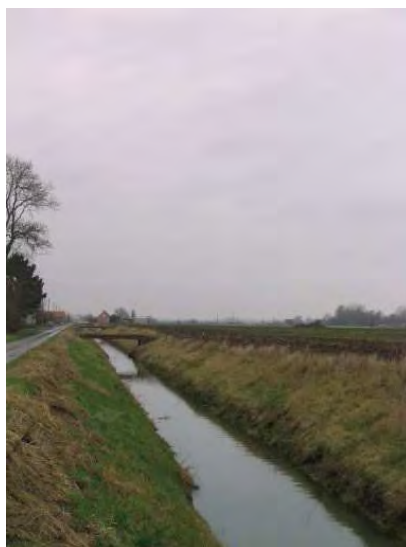
Méteren Becque – Rue du Courant aval
