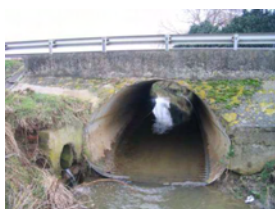
Confluence Fossé des Prés – Méteren Becque
