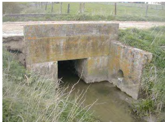
Figure 13 : Ouvrage amont (route).
