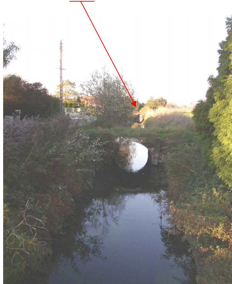
Ouvrage n° 15 (arrière plan) - Ouvrage n° 16
