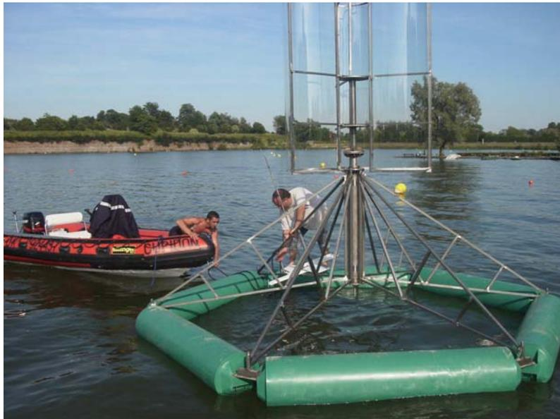
Figure 8. Implantation des hydroliennes par AEROLAC SAS le 22 juin 2004 sur l'étang du Pont Rouge
