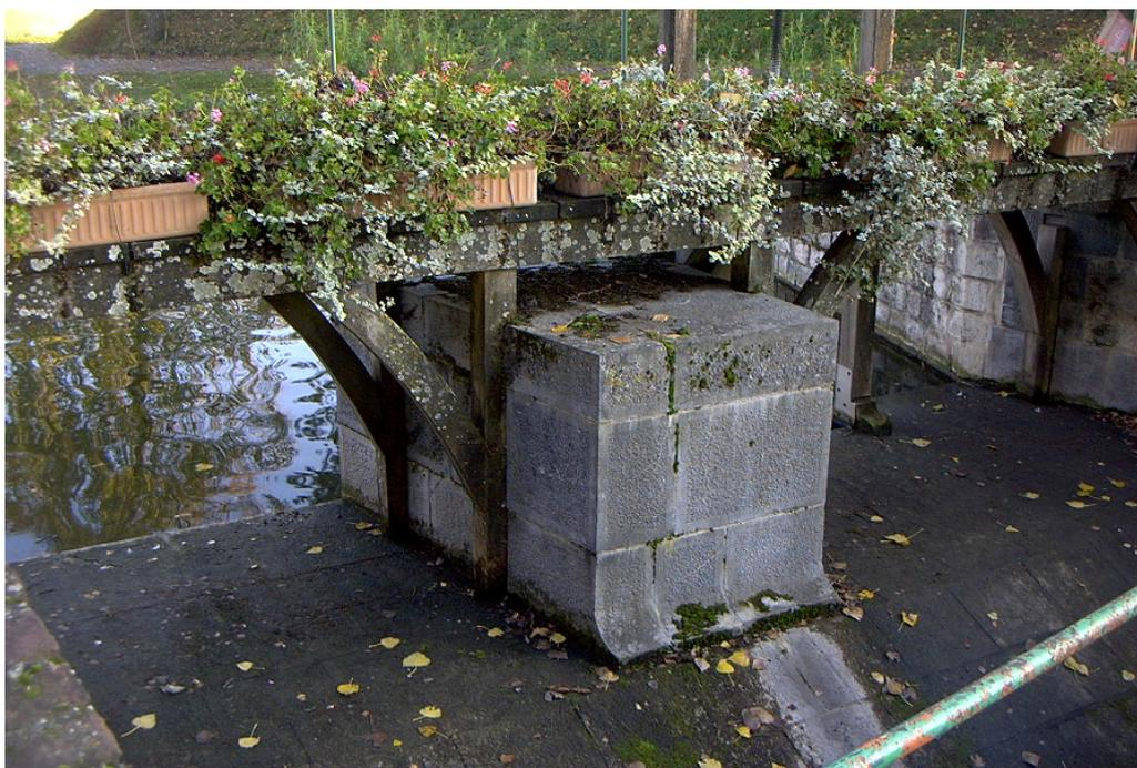
Figure 4. Vannage situé à l'exutoire du plan d'eau
