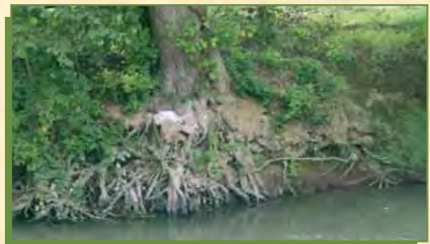
Le système racinaire des arbres stabilise les bas des berges
