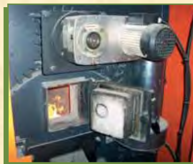
Les chaudières à bois sont de plus en plus utilisées, notamment par les collectivités
