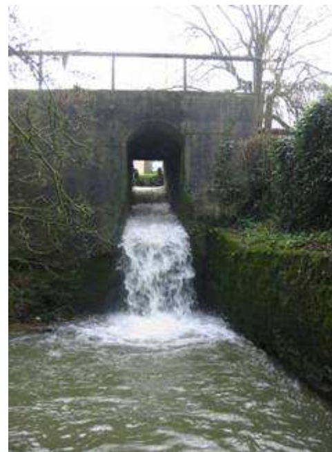
Barrage infranchissable sur la Slack
