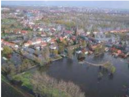
Figure 9 : Vue aérienne des dégâts causés par la crue de 2001 (source : AMEVA)
