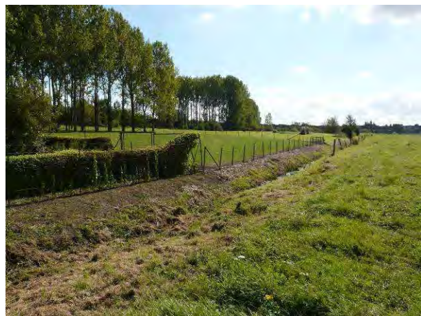
Fossé au Nord de Malhôte. Elargissement à étudier localement (F2.7)
