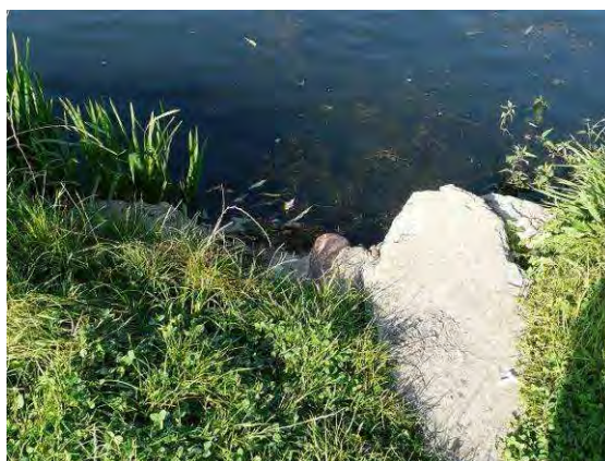
Arrivée d'eaux pluviales dans Beauséjour
