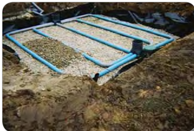
ANC - Pose de drains d'épandage
