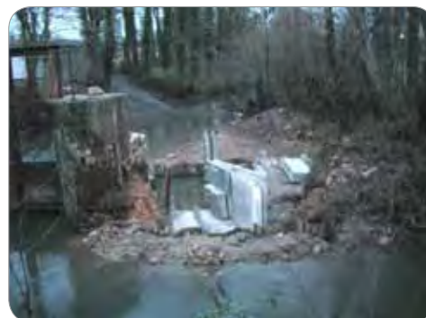
Travaux d'aménagement d'une passe à poissons - Ouvrage de la tour des chaussées à Hesdin
