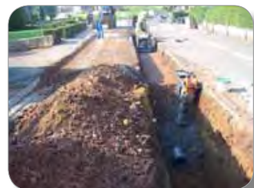
Pose de réseaux d'assainissement
