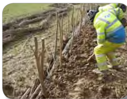
Implantation de fascines contre l'érosion à Seninghem
