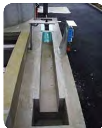
Exemple de dispositif d'autosurveillance : canal venturi équipé en sortie de STEP
