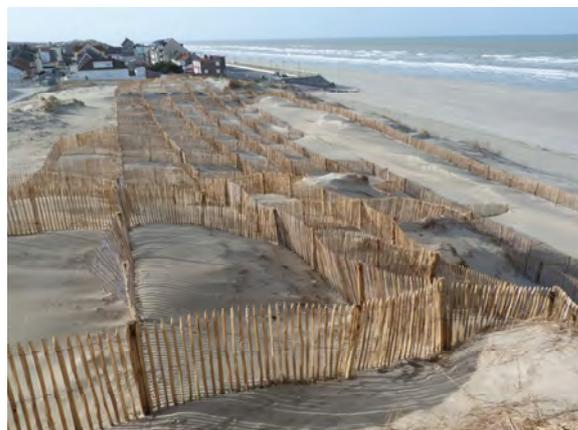
Figure 15 – Travaux de protection de la dune bordière – B. Régèle
