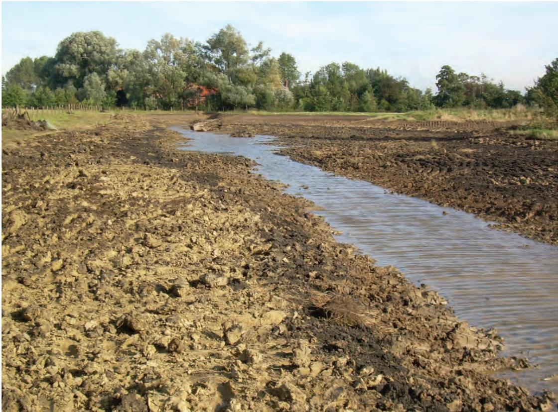
Profilage de l'annexe alluviale avec son chenal central avant mise en eau (AEAP)
