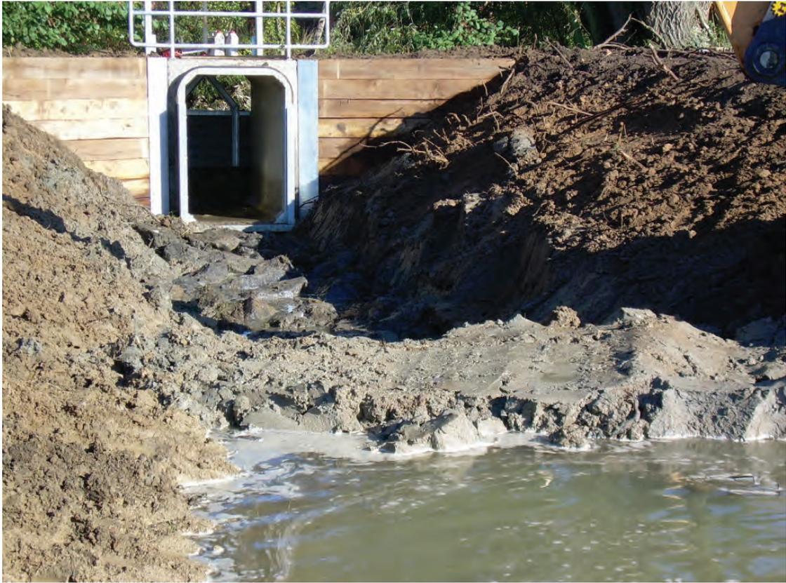
Installation du dispositif permettant la gestion des niveaux d'eau de la frayère (AEAP)
