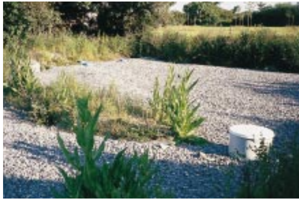
ÉPURATION PAR LE SOL : ÉPANDAGE SOUTERRAIN.
