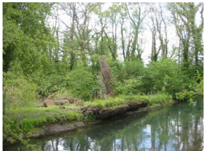
Figure n°28 : Déchaussement des digues par les arbres (T4).
