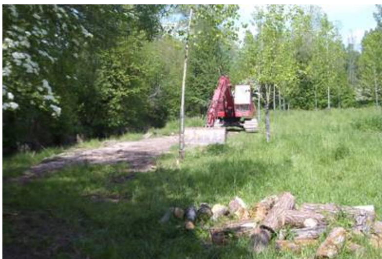
Figure n°53 : Mise en œuvre de l'arasement du bourrelet de curage sur le tronçon 6.
