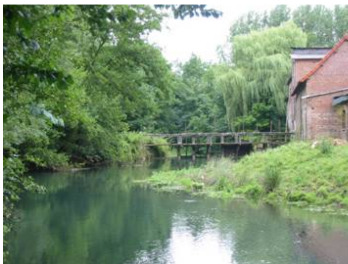
Figure n°21 : Effet plan d'eau en amont d'un barrage sur l'Authie.
