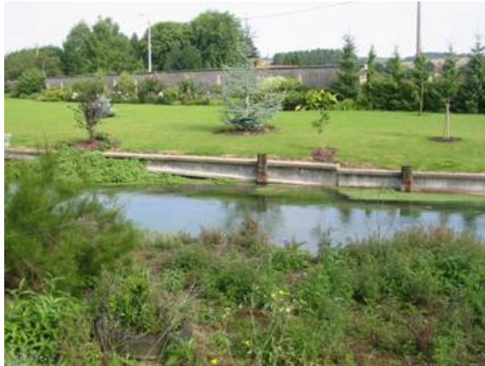
Figure n°16 : Protection de berge sur l' Authie .
