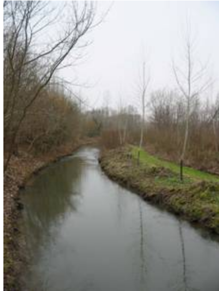
Figure n°14 : Rectification du lit mineur sur l'Avre.
