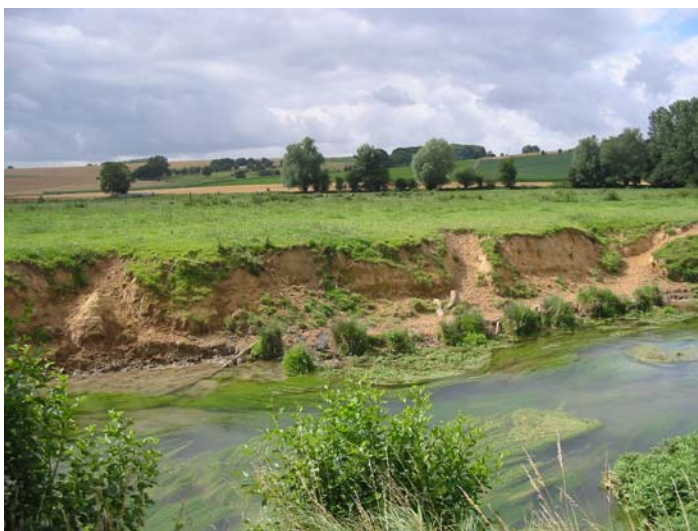
Figure n°30 : Effondrement des berges (T5).
