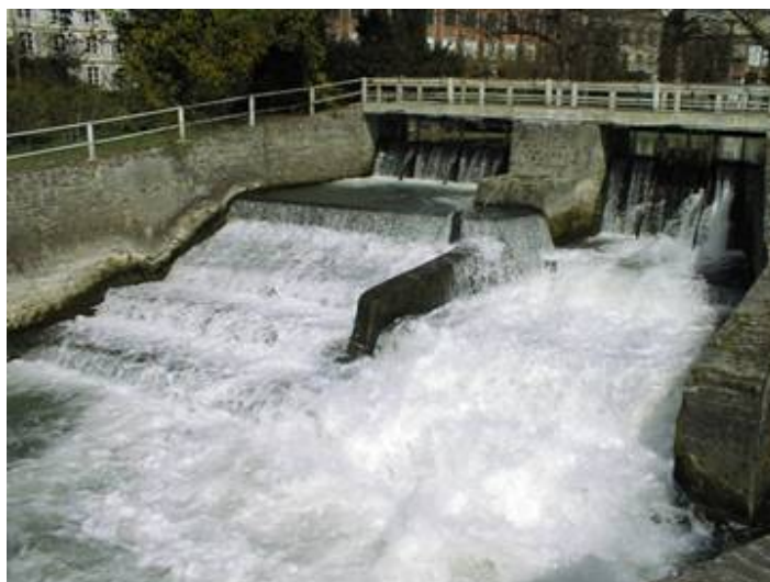
Figure n°20 : Seuil infranchissable sur la Ternoise .
