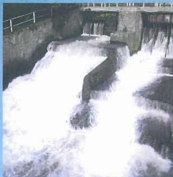
Barrage à Auchy les Hesdin
