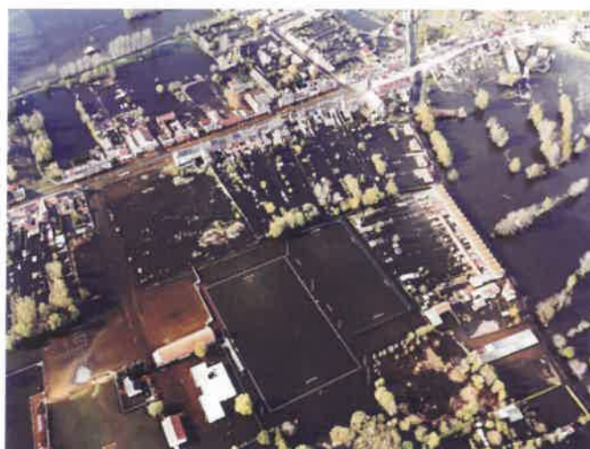
Une zone particulièrement sensible aux inondations (Abbeville inondée par les remontées de nappe de la Somme en 2001)
